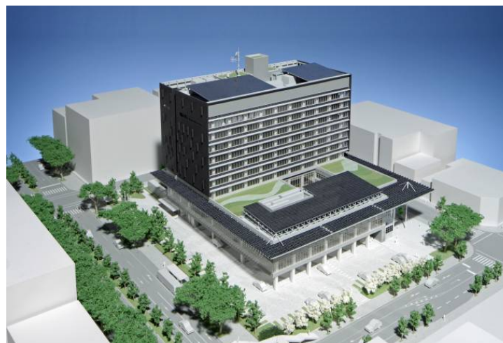
地中熱利用設備が導入された甲府市庁舎
