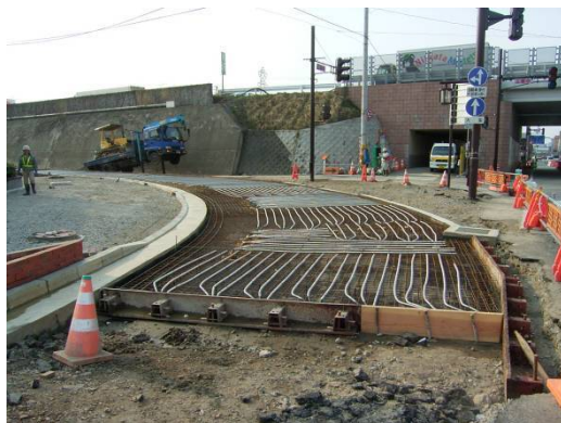
ヒートパイプ敷設状況
