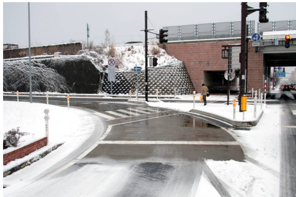
地中熱による融雪状況
