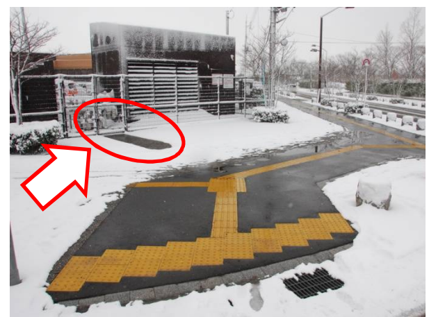
機械設備アプローチ 24
