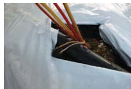
冷水パイプによる“クラウン冷却”
