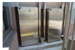
地中熱ヒートポンプ(10kW×2台)
