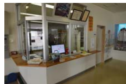
運転状況モニター
