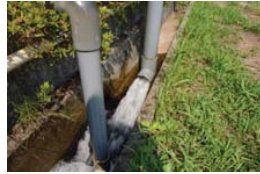
地下水排水状況
