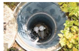
地中熱熱交換器(100m)
