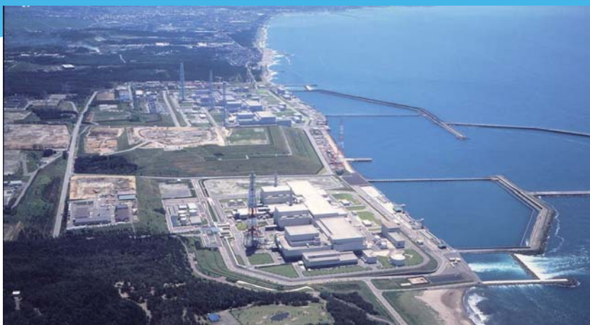
柏崎刈羽原子力発電所
