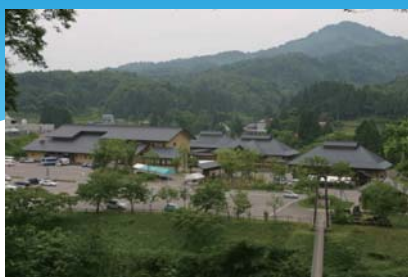
ペレットボイラー(580kW)
