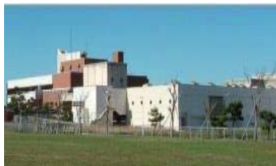
消化ガス発電(95kW×2基)
