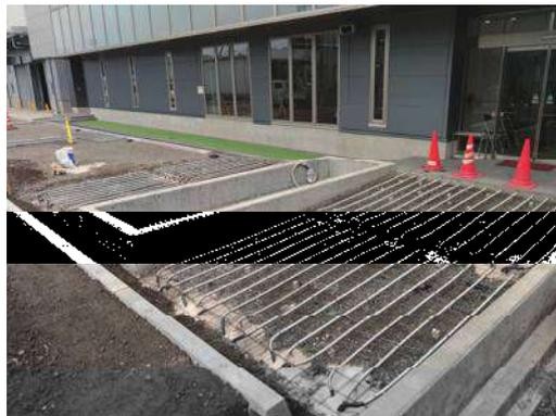
施工時（ヒートパイプ敷設・Co舗装施工前）
